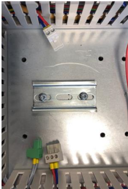
Schiene der DCOM Platine anschrauben
