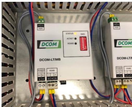
Schiene der DCOM Platine anschrauben
